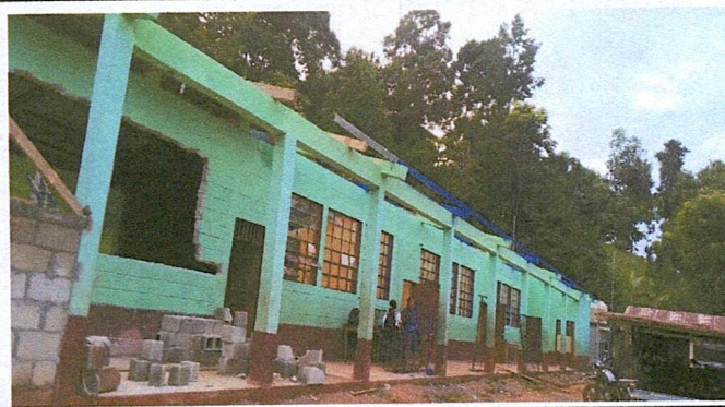
Foto 2: Destechado de cubierta del establecimiento.
